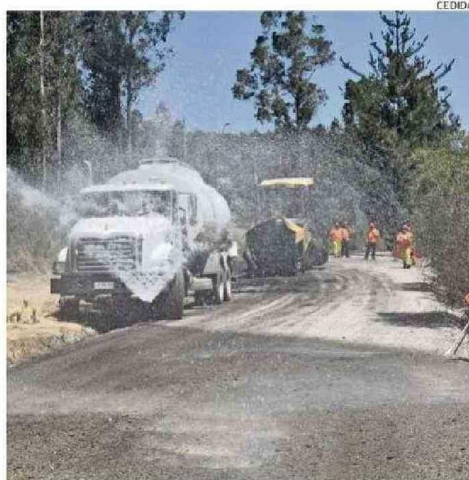
TRAMO PAVIMENTADO ALCANZA LOS 2 KILÓMETROS EN TREHUACO.
