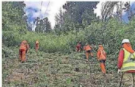
Junto a la comunidad y con todos los recursos en terreno la compañía avanza para asegurar el mantenimiento de su red eléctrica
