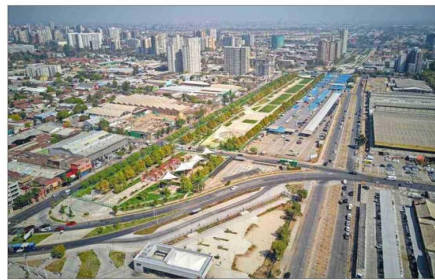
PARQUES INUNDABLES. — Este tipo de espacios como el construido entre San Miguel y San Joaquín es parte de la infraestructura que se pide.
