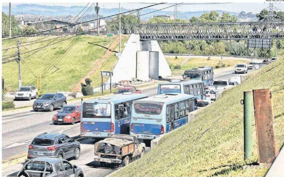
LA ESTRUCTURA SOBRE LA AUTOPISTA EN TALCAHUANO PERMANECERÁ EN EL LUGAR, SIN USO, A LA ESPERA DE QUE AUTORICEN SU DESMONTE.
