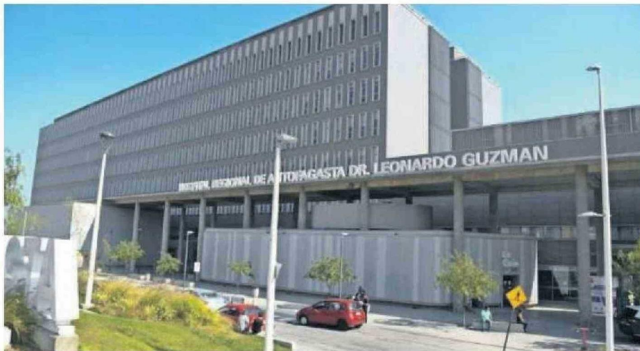
VAN MÁS DE 30 CIRUGÍAS QUE SE HAN TENIDO QUE SUSPENDER POR LA FALLA DEL SISTEMA DE CLIMATIZACIÓN.
