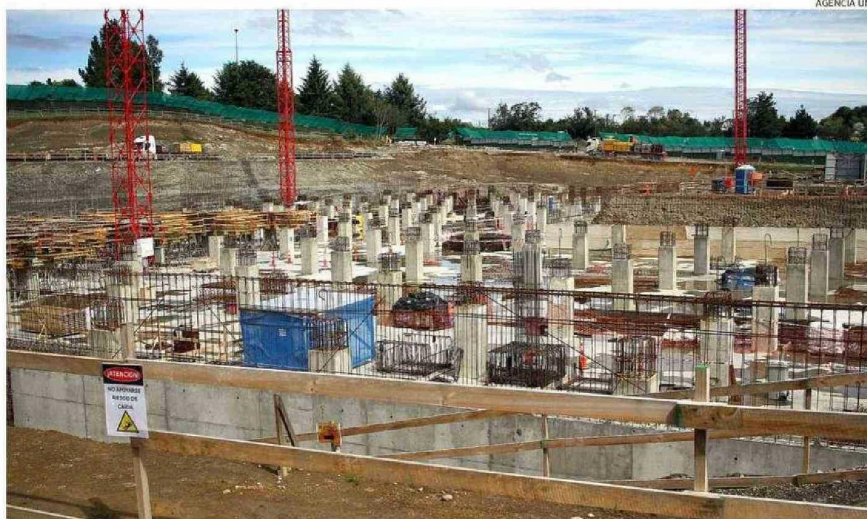
EL SEREMI DE OBRAS PÚBLICAS EXPLICÓ QUE EL PROYECTO MARCHA DENTRO DE LOS PLAZOS ESTABLECIDOS.
