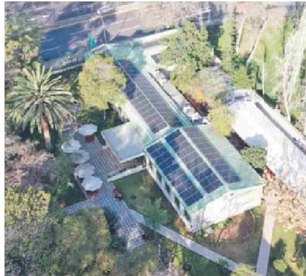
Vista aérea de los paneles solares sobre la Biblioteca de Casa Central de la Universidad Bernardo O'Higgins.
