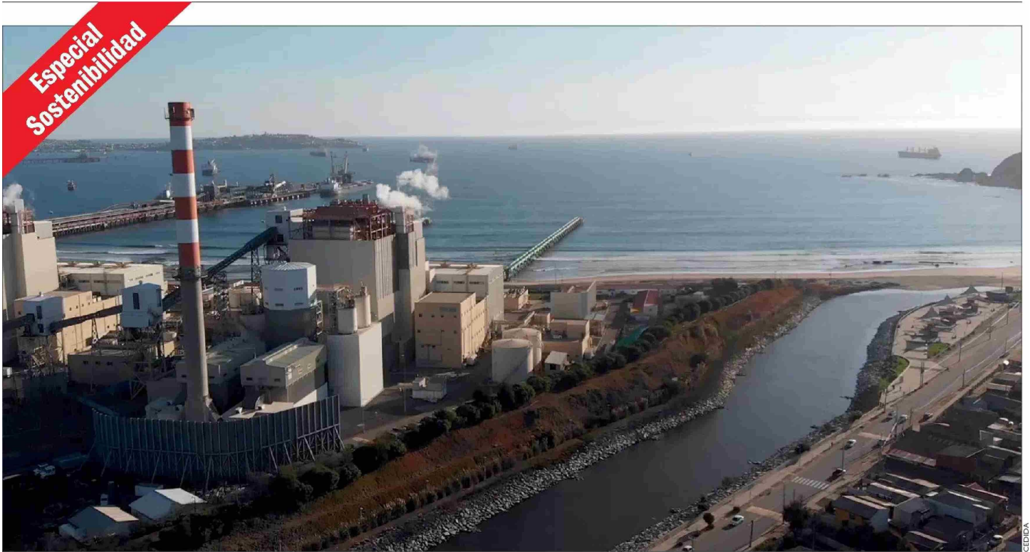
El complejo termoeléctrico Ventanas 2 cesó sus funciones el 31 de diciembre de 2023.
