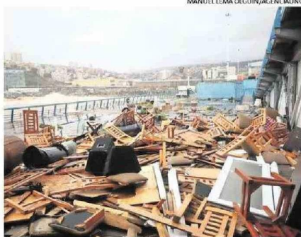
MAREJADAS AFECTARON A UN RESTAURANT EN VALPARAÍSO.
