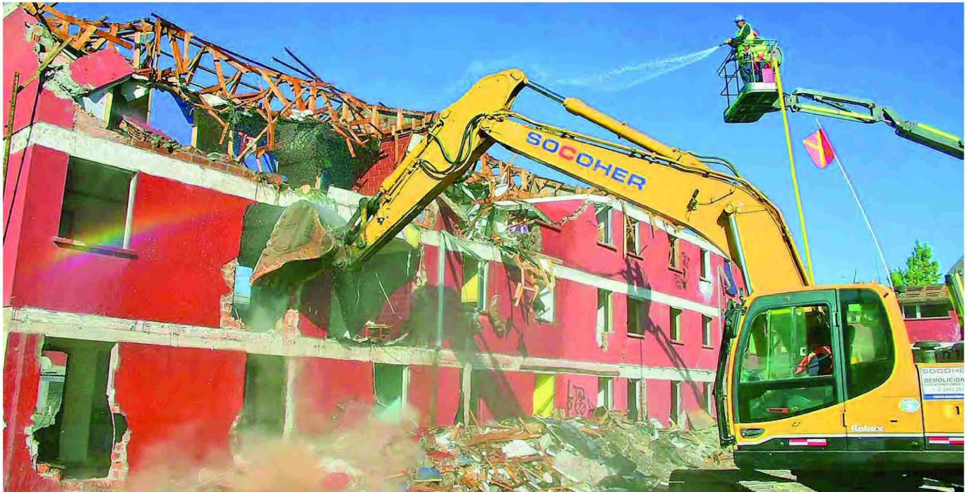
Gobierno compromete fechas para tercera demolición de los edificios de departamentos de Las Américas en Talca.
