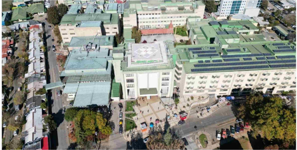
EL COMPLEJO ASISTENCIAL de Los Ángeles siguió funcionando de manera normal.
