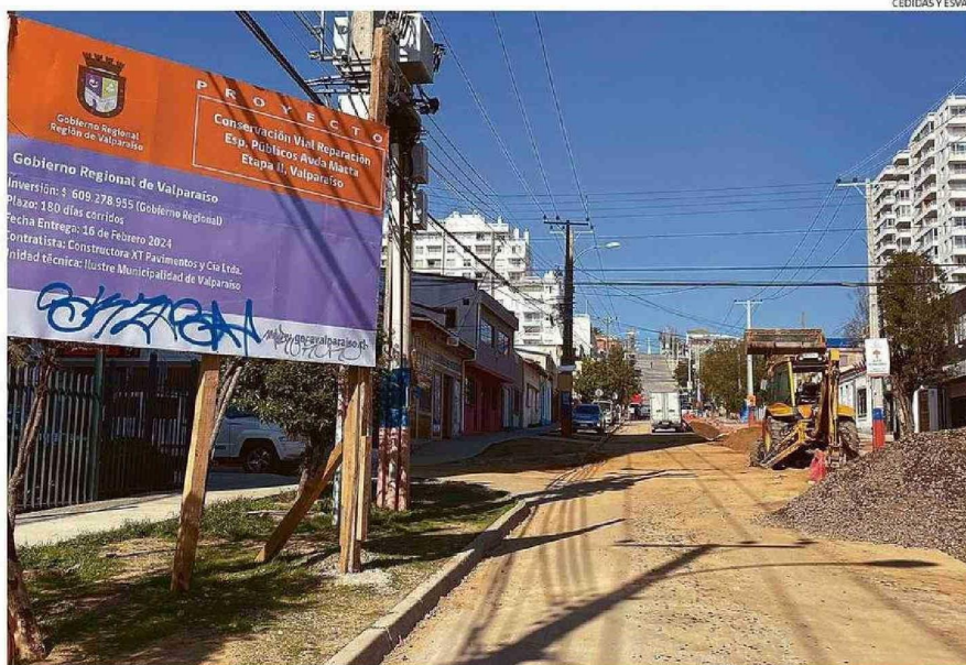
AÚN SIGUE CARTEL CON FECHA DE ENTREGA: 16 DE FEBRERO 2024. VECINOS ALEGAN QUE OBRAS HAN ESTADO EN ABANDONO POR AÑOS.
