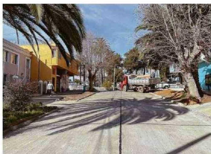
$325 MILLONES: RENOVACIÓN DE REDES DE ESVAL EN AV. MATTA.
