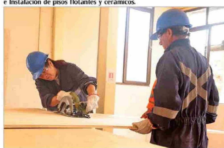
Becas Laborales Técnicas constructivas domiciliarias e Instalación de pisos flotantes y cerámicos.
