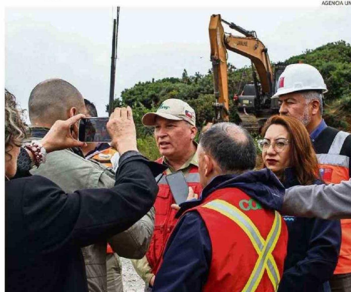
LAS AUTORIDADES JUNTO A LA MAQUINARIA QUE COMENZABA A REALIZAR FAENAS CERCA DEL HOSPITAL.
