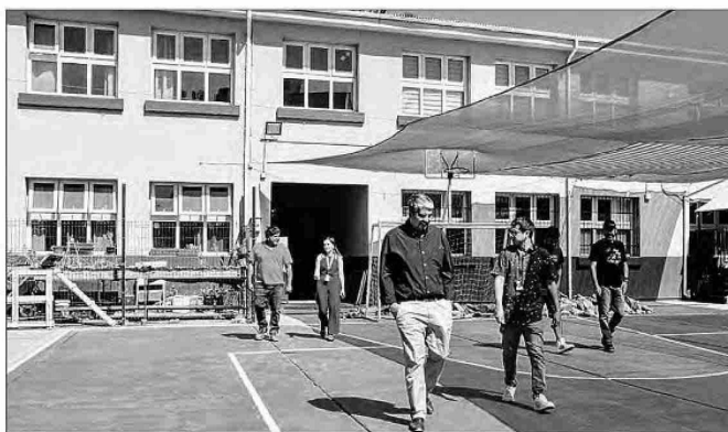
Varías son las obras que se están desarrollando en los establecimientos educacionales de la comuna.
