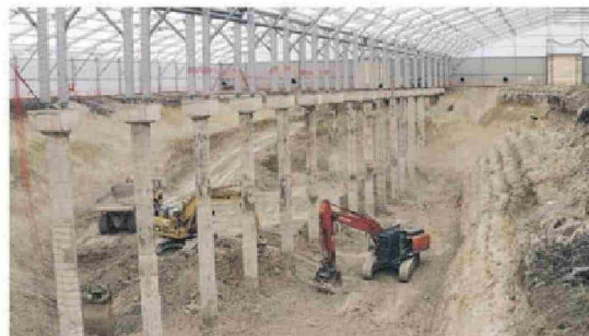
Remediación en Saint Denis (Francia).
