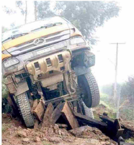
El vehículo pesado cruzó la estructura de madera, con un sobrepeso de tres veces lo permitido.
