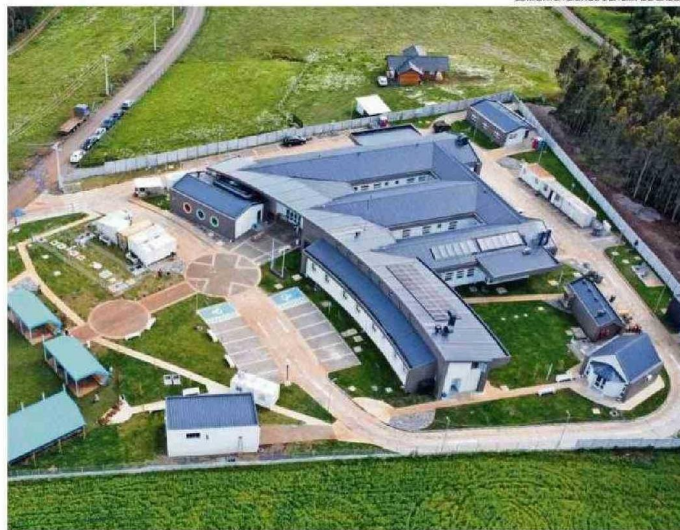
EL CENTRO DE SALUD INTERCULTURAL BOROA FILULAWEN ESTÁ PRÓXIMO A CULMINAR LAS OBRAS Y SER INAUGURADO.
