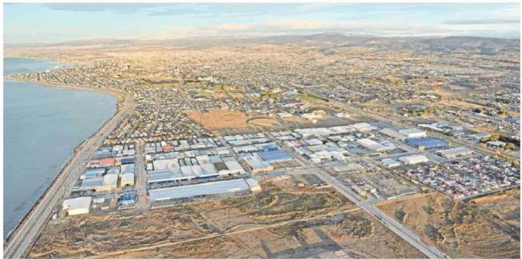
La Zona Franca ha ido ampliando su oferta. Ahora se proyecta que, en el terreno contiguo a Central de Carnes, se instalará un centro médico.
