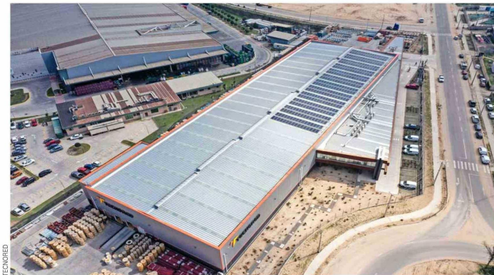
Instalaciones del Centro de Distribución de TecnoRED en Placilla, Valparaíso.
