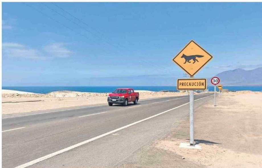
COMO PARTE DE LA CAMPAÑA SE HAN INSTALADO SEÑALÉTICAS EN LAS CARRETERAS.
