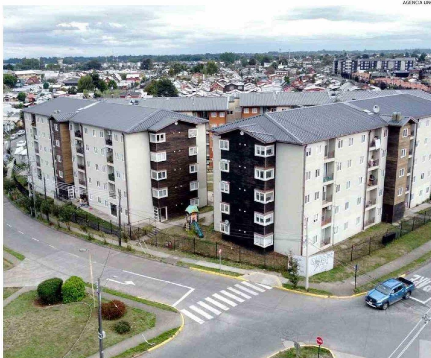
EL PROBLEMA SE REGISTRA EN EDIFICIOS DE RAHUE ALTO, CHUYACA Y EL SECTOR ORIENTE, DONDE LOS DUEÑOS COMPRARON CON SUBSIDIOS ESTATALES.
