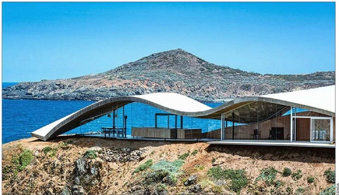
El techo, de 50 metros de largo, se construyó con hormigón armado.
