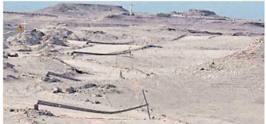
SE ESTIMA QUE LA REPOSICIÓN DE POSTES Y DE LA LÍNEA ELÉCTRICA SE PRODUZCA LA PRÓXIMA SEMANA.
