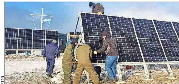
Funcionarios de la Armada de Argentina, al retirar los paneles en la zona del Hito I, en el área del territorio chileno, al norte de Tierra del Fuego.
