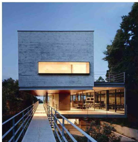
Una estructura desafiante tiene esta obra en Buenos Aires.
