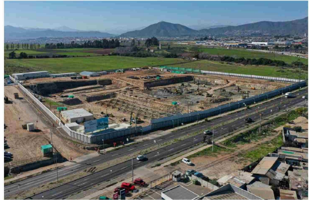
Se espera que a fin de año la obra presente un 15% de avance, según la proyección de la ministra del MOP.
