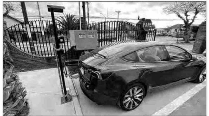
Quienes tengan un vehículo eléctrico podrán cargarlo en el Colegio Fundadores, ya que instaló un cargador que funcionará gratuitamente durante el primer mes.
