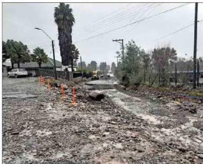
SAN CLEMENTE.— Lluvias que superaron los 100 milímetros en un día colaboraron a generar un nuevo corte en la ruta K-679, en Maule.
