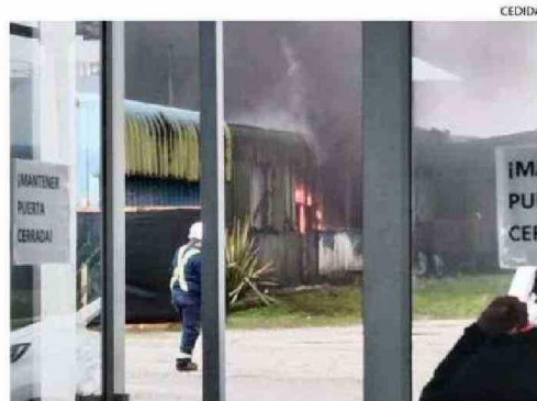
PARTE DE LAS INSTALACIONES ARDIERON.
