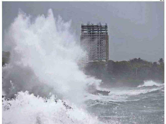
OLEAJES DESMESURADOS PROVOCARON ESTRAGOS Y SOCAVONES EN DISTINTAS LATITUDES.
