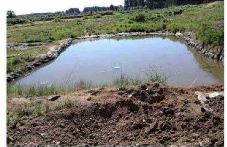
LOS LÍQUIDOS LIXIVIADOS SE ESTARÍAN FILTRANDO DE LAS PISCINAS.
