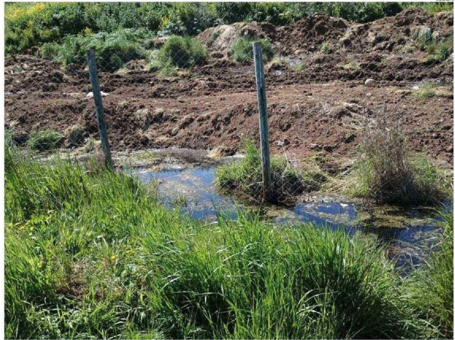
EL BARRO Y LOS LÍQUIDOS LIXIVIADOS ESTANCADOS SE PUEDEN VER EN LA ORILLA DEL CAMINO VECINAL EN CURACO.
