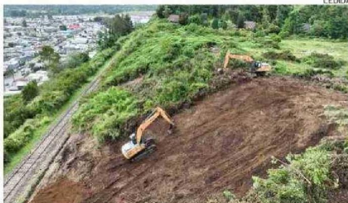
CON EXCAVADORAS HAN ESTADO REALIZANDO LOS CORTAFUEGOS.
