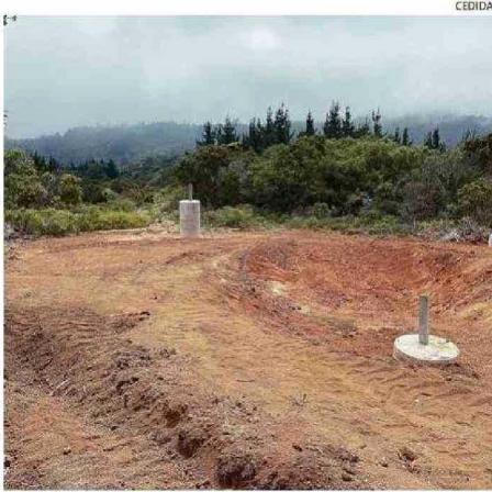
LA SMA REALIZÓ VISITAS INSPECTIVAS EN TERRENO.
