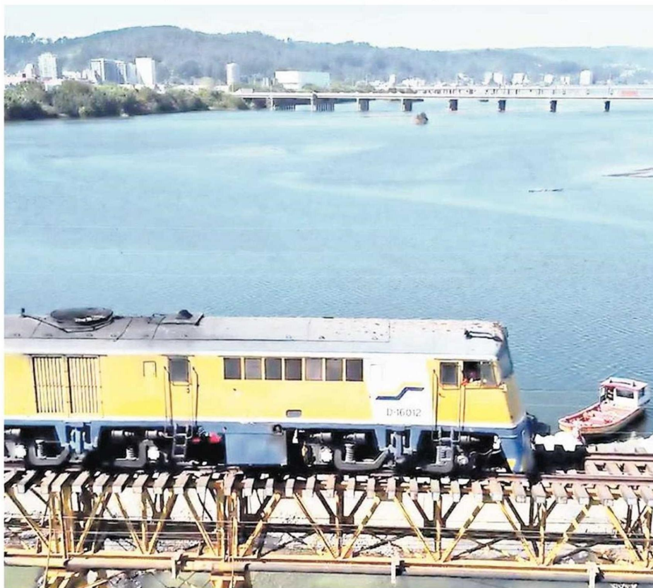
Esta semana partieron las pruebas de trenes de carga por el viaducto.
