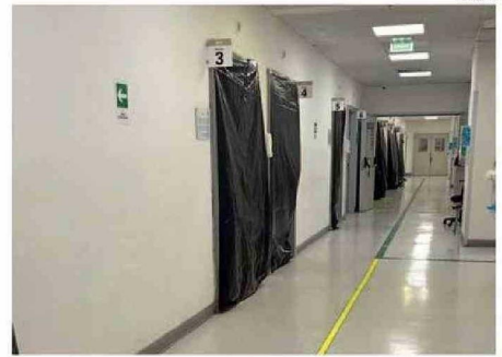
COMENZARON LOS TRABAJOS EN LOS BOX DE ATENCIÓN.
