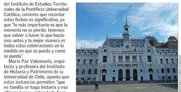
EN VALPARAÍSO. — El Edificio de la Armada también abrió sus puertas, de manera virtual, al público.
