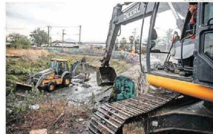
CON MAQUINARIAS INTENTABAN DESPEJAR CAUCES.
