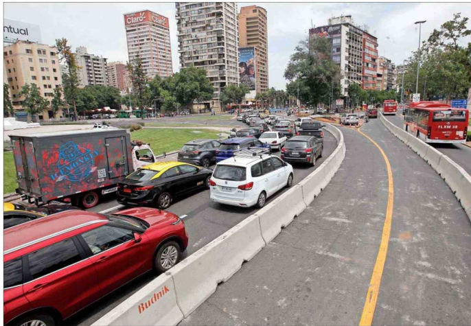
PROYECTO. — Los trabajos que comenzaron ayer se enmarcan en la iniciativa Nueva Alameda que considera una inversión de $26 mil millones e involucra a ministerios, municipios y al Gobierno de Santiago.
