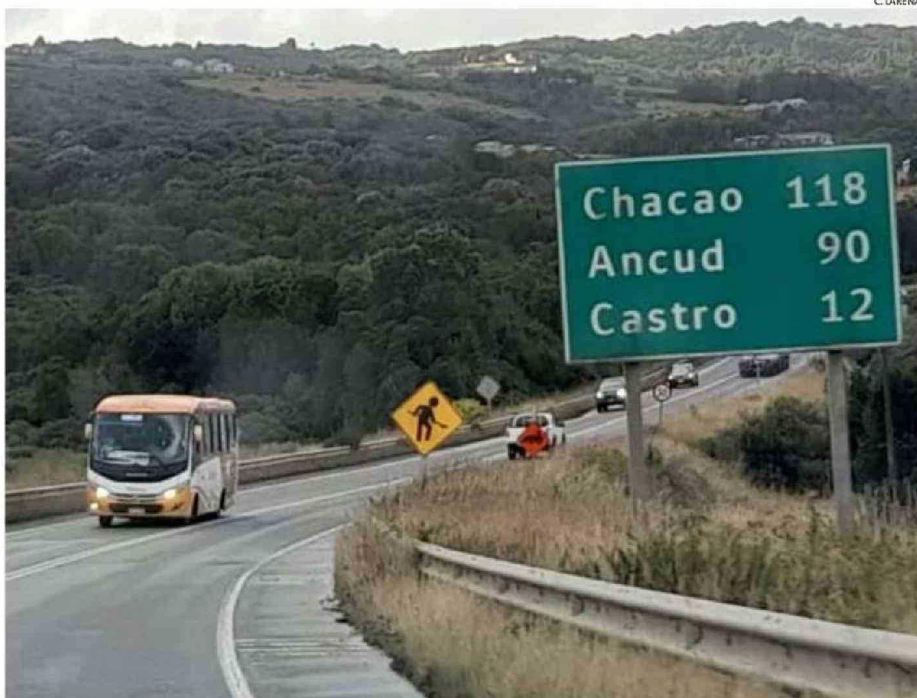
LA NECESIDAD DE MEJORAR EL ESTÁNDAR DE LA RUTA 5 SUR EN CHILOÉ ES UN ANTIGUO RECLAMO DE LA COMUNIDAD INSULAR.
