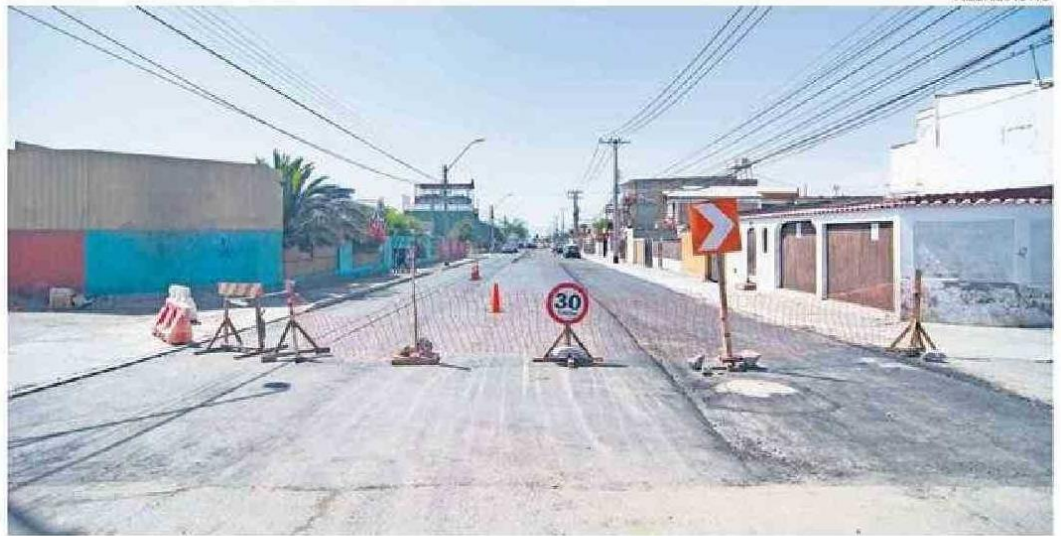
OBRAS SE ENMARCAN EN PROBLEMAS SANITARIOS QUE EL SECTOR HA TENIDO DURANTE 40 AÑOS.
