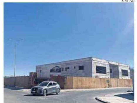
LA CONSTRUCCIÓN DEL CEFSAM SUR ESTÁ DETENIDA DESDE EL AÑO 2018.
