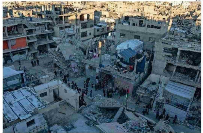
EN TOTAL SE PROYECTA CONSTRUIR UNAS 460 MIL VIVIENDAS PARA ALOJAR A TRES MILLONES DE PERSONAS.
