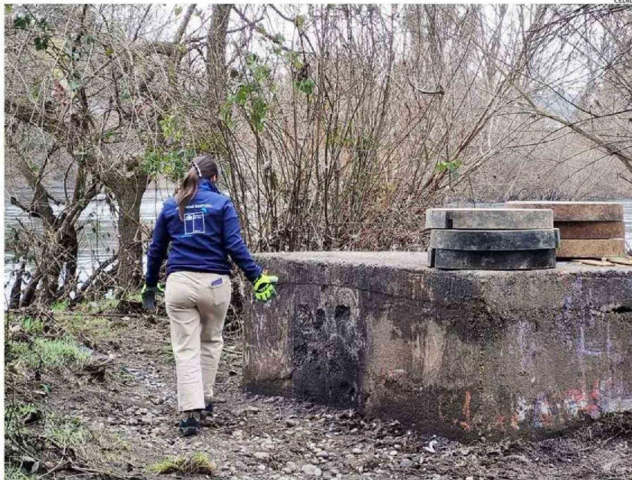
EN LA INSPECCIÓN SE CONSTATÓ UNA SEVERA CONTAMINACIÓN POR AGUAS SERVIDAS EN EL DELICADO ECOSISTEMAS DE LOS RÍOS DE OSORNO.
