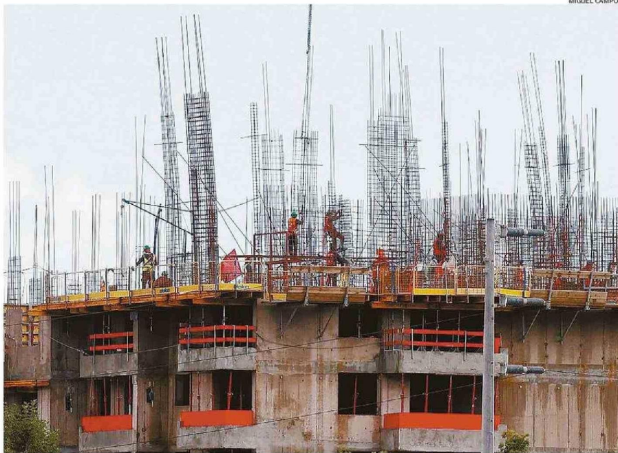
EL MONTO EN LA CARTERA DE PROYECTOS ES LIDERADA POR EL SECTOR INMOBILIARIO CON INVERSIONES POR US$ 478 MILLONES.
