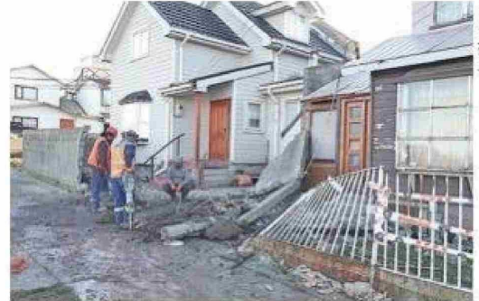
Personal a cargo realizaba trabajos este domingo para reparar los medidores de gas destruidos en las viviendas signadas con los números 642 y 646 de Avenida Pedro Aguirre Cerda, al sur de Punta Arenas.
