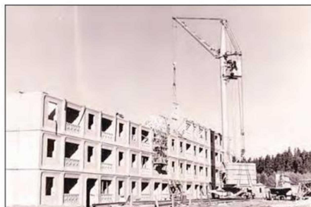
El proceso de construcción de la KPD era tan rápido, que en 2 semanas podía levantar un edificio con una cuadrilla de solo 14 trabajadores.
