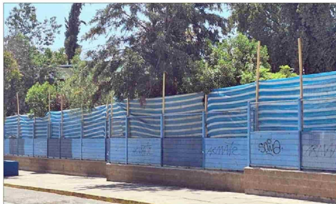
Comenzaron las obras de mejoramiento en la Escuela José de San Martín.
