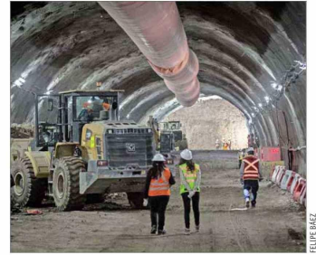
En las obras donde conectan AVO I y II, las faenas se extienden día y noche, todos los días de la semana.
