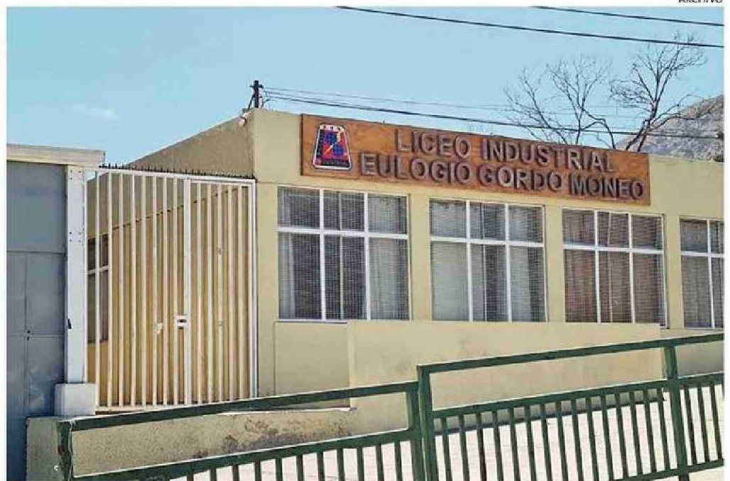
SE REALIZARÁ UNA INTERVENCIÓN EN EL LICEO INDUSTRIAL.
